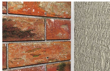
Konštrukčný spoj na styku stena/stena
